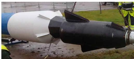
Pour éclater de tubes en béton armé.
